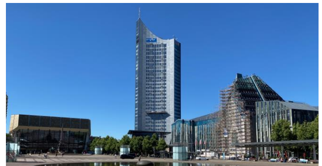
v.l.n.r.: Neues Gewandhaus, Panorama-Tower, Universität
