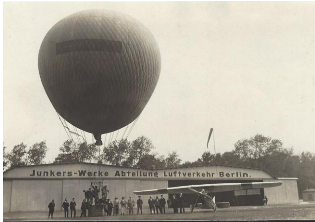
Der erste Hangar in Tempelhof für die Fluggesellschaft Junkers-Luftverkehr.
