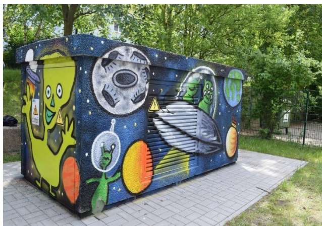
Foto: Trafostation gestaltet von der Grundschule am Bürgerpark / Marzahn-Hellersdorf, Mai 2018
